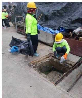
5-12 ล้างทำความสะอาดบ่อพักตะกอนและท่อระบายน้ำ
