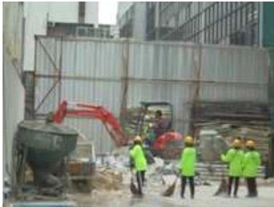
ภาพที่ 5-28 ตักเศษวัสดุก่อสร้างขนออกไปสู่ภายนอกโครงการและติดตั้งสเปรย์น้ำม่านน้ำบริเวณด้านหลังที่ติดกับอาคารข้างเคียง
