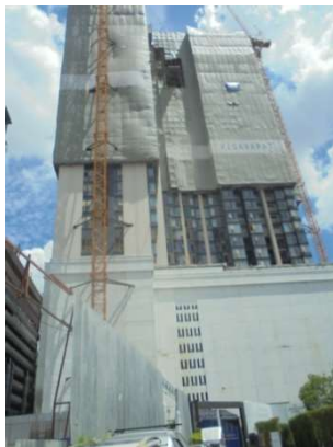
ภาพที่ 5-20 ปิดคลุมอาคารตามชั้นความสูงที่ก่อสร้างไว้ และใช้ทาวเวอร์เครน
